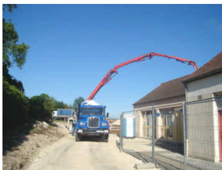
Coulage de la dalle
