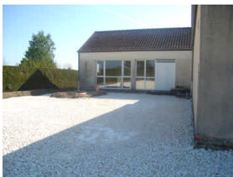
Préparation du terrain
