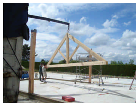
Mise en place poteaux
