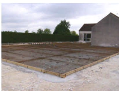
Pose du treillis
