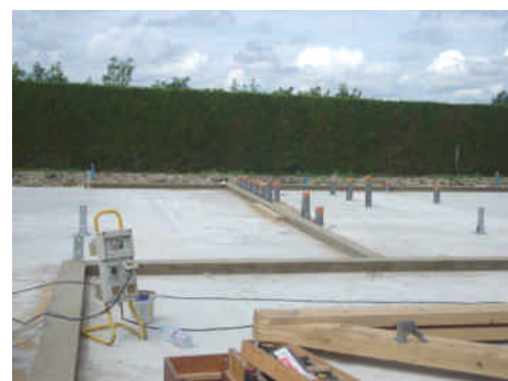
Ancrage supports au sol
