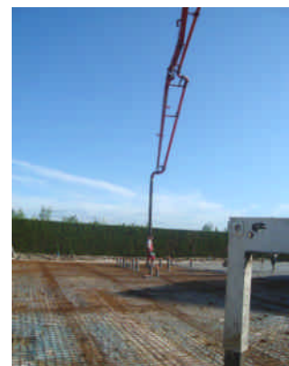
Coulage de la dalle
